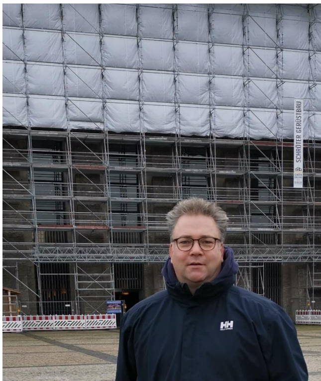
Immerhin gehen die Bauarbeiten für das Sportmuseum unterhalb der Tribünen des Maifeldes und in den Vorräumen der Langemarckhalle nach langem hin und her endlich voran.
